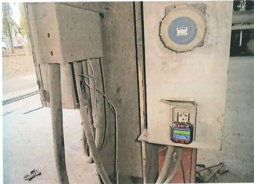
ตรวจสอบการติดตั้งระบบสายดินของอุปกรณ์
